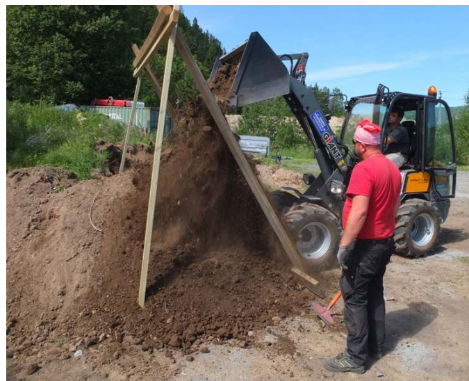
Jordmassen ble siktet for røtter og større stein.
