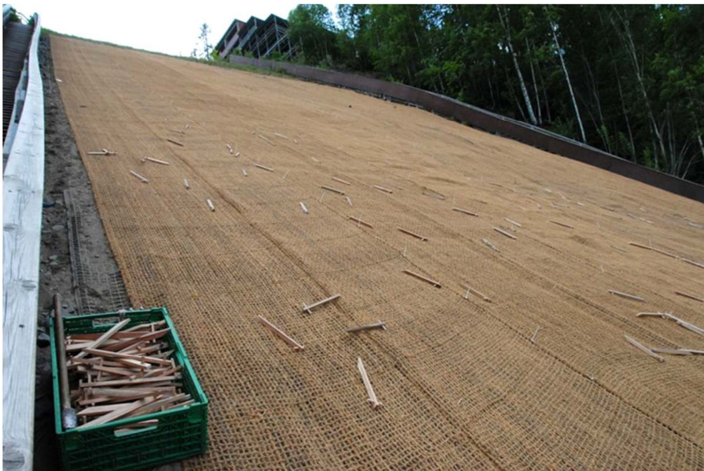
Kokosmatter legges over jord som er tilsådd for å forhindre erosjon ved styrtregn
