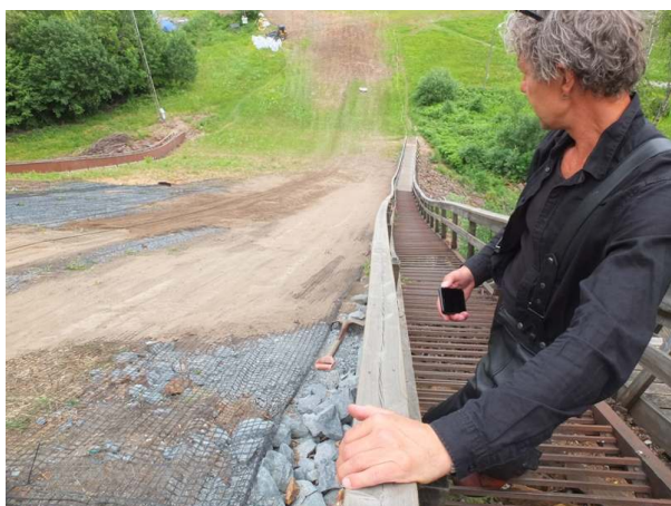
Edvard Undall fra Akershus fylkeskommune på befaring i unnarennnet.
