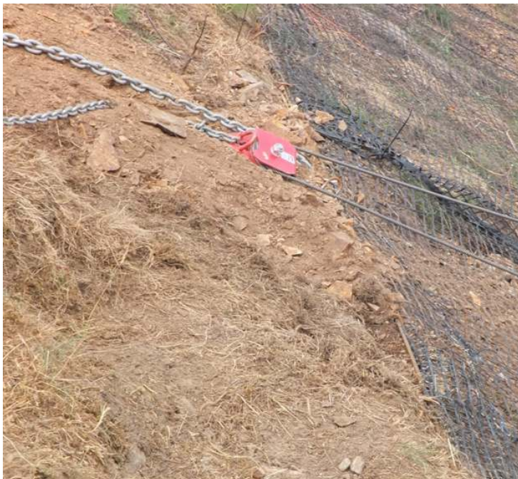
Lang wire gjennom kasteblokk festet i fjell for å trekke opp massene trukket av en liten traktor på sletta.
