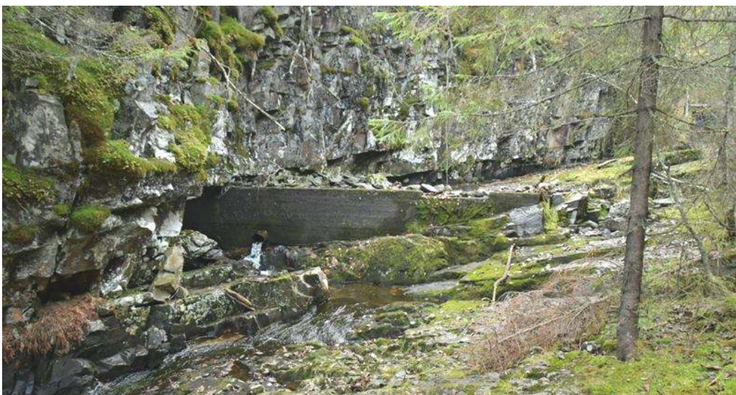
Demningen i Urselven for tilleggsvann til Stovivannet. Bygget på 1950 tallet.
