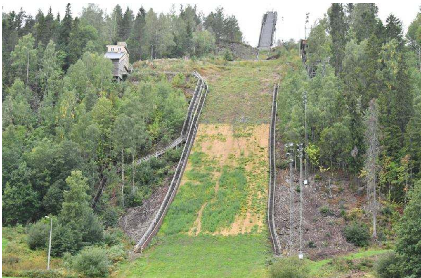
Unnarennet er tilbakeført uten groper og gror til. Kokosmattene forsvinner etter som nye gress og engplanter binder jorden.
