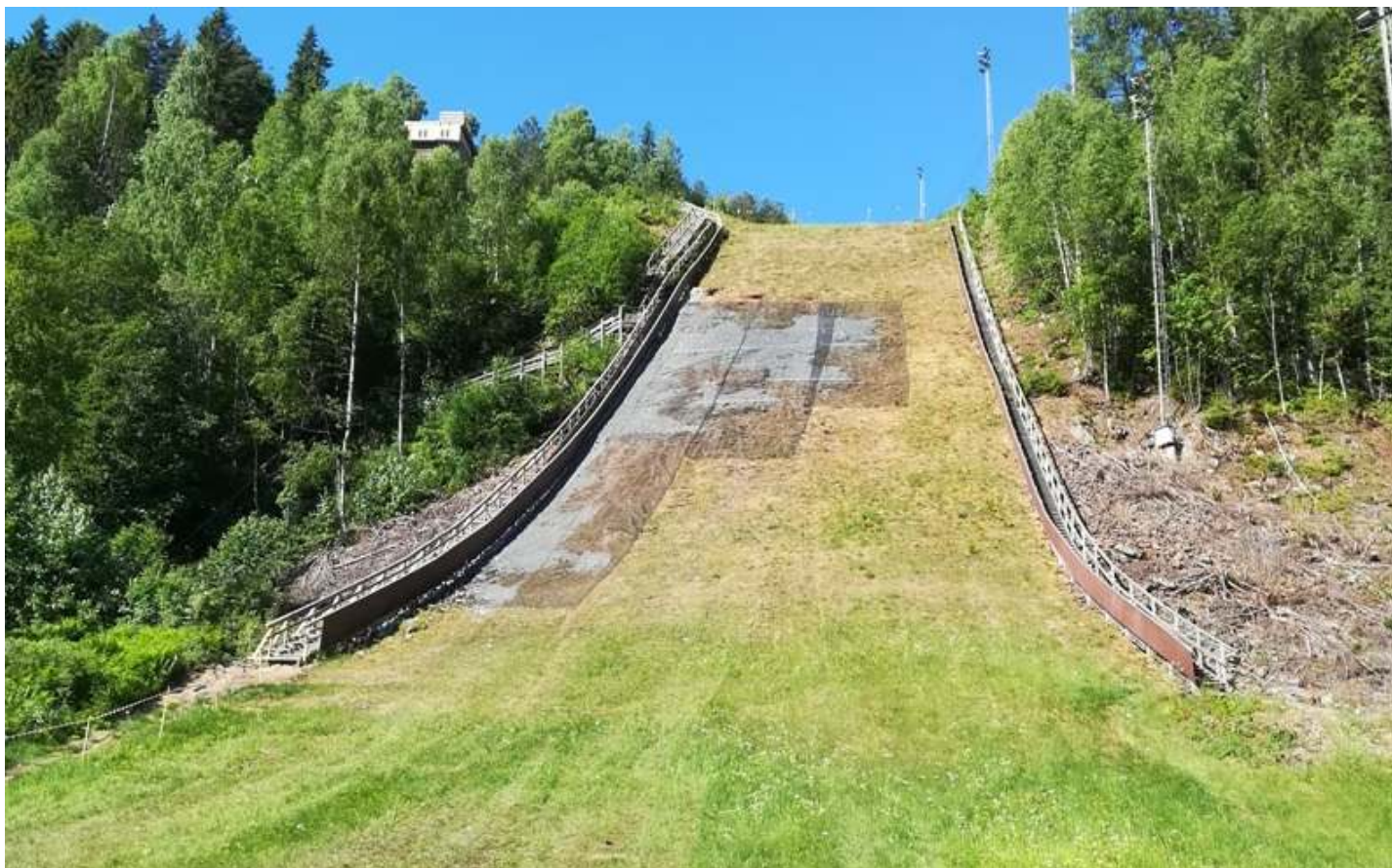
Geonett forankret til fjell lagt ut på toppen av stein og pukk.
