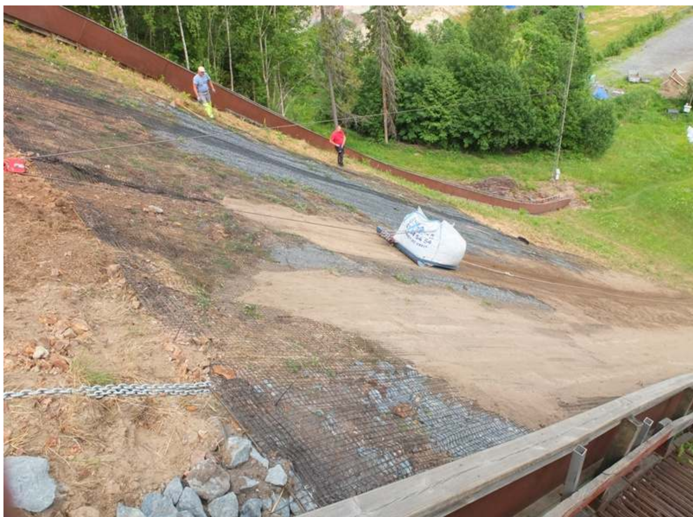
Steinmassene dekkes med jord som trekkes opp i storsekk på slodd, som det ble gjort med steinmassene.
