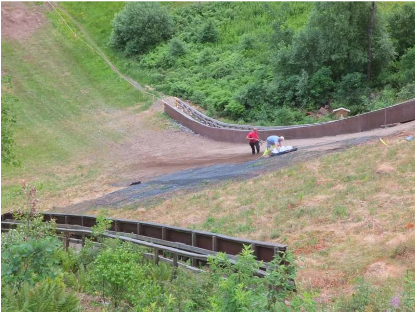
Steinmassene dekkes med jord som trekkes opp i storsekk på slodd, som det ble gjort med stein.
