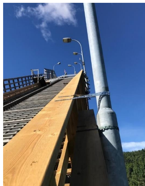
Over: Rekkverk nord fornyet og lysmast solid og stødig innfestet. Foto Ole Kristoffersen
