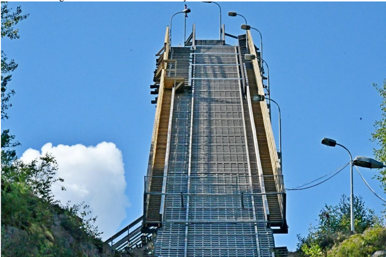
Rekkverk og utkragede trapper på begge sider av tilløpet er skiftet ut.
