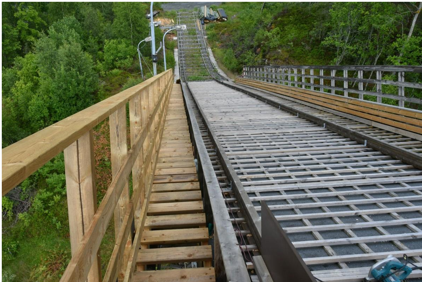
Nytt rekkverk og trapper på nordsiden. Rekkverket er rett og solid og ikke skjevt pga lysmastene
