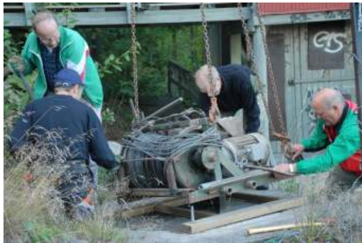
Vinsjen for preppetrommelen i unnarenn er tilbake på plass. Takk til Thomas Fredriksen med superlang kran.
