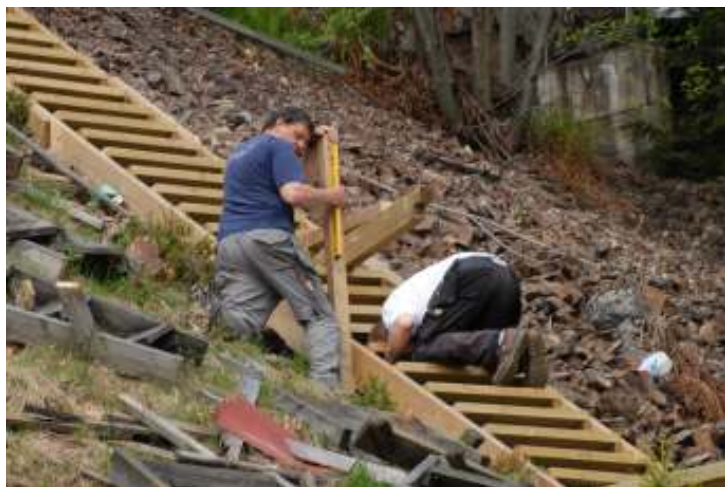
Måle/trimmetrapp under oppbygning
