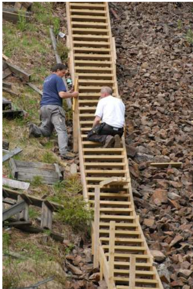
Nordre måle/trimmetrapp under restaurering av Jostein Ringstad og Egil Lyngstad
